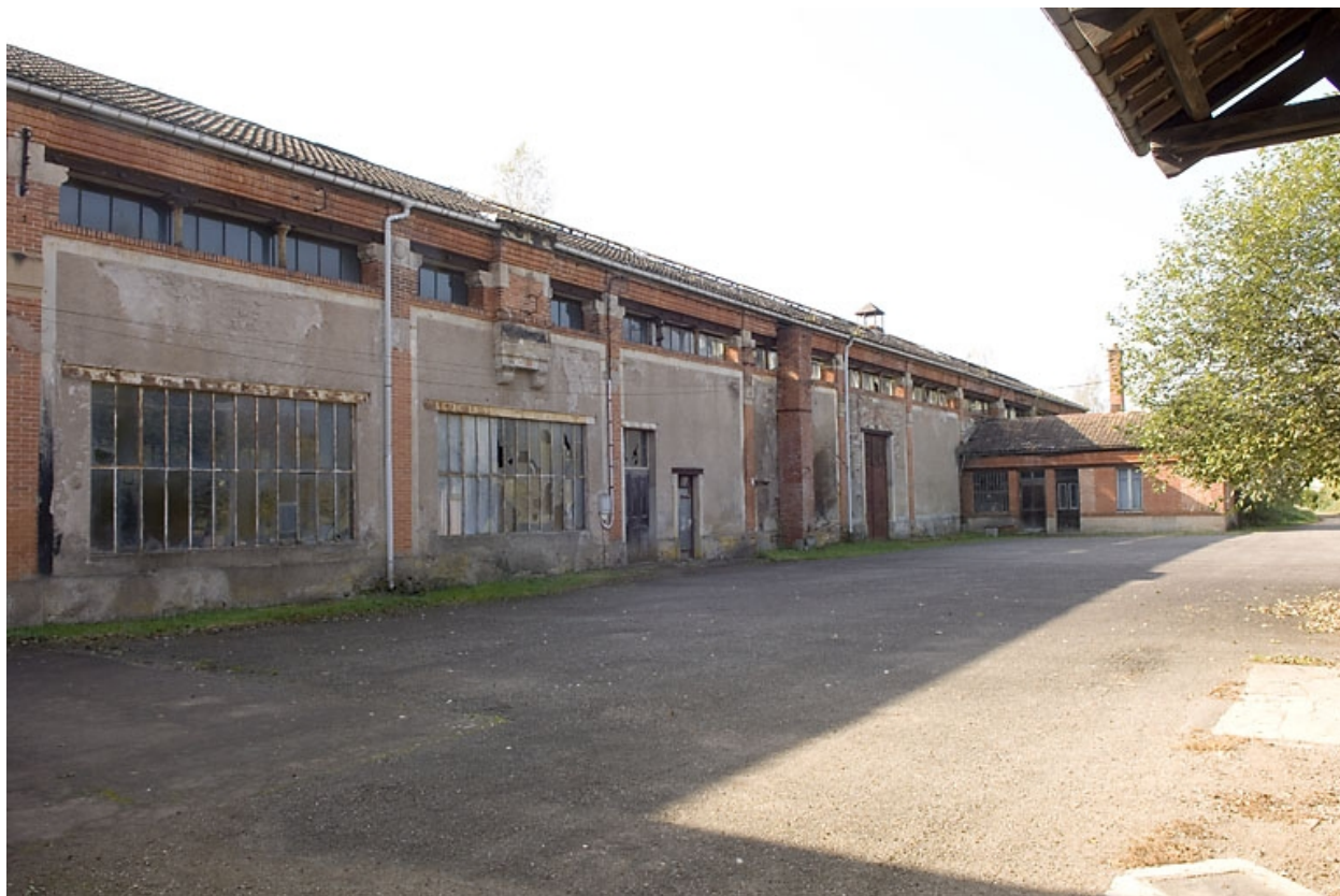
Façade antérieure depuis l'est.
