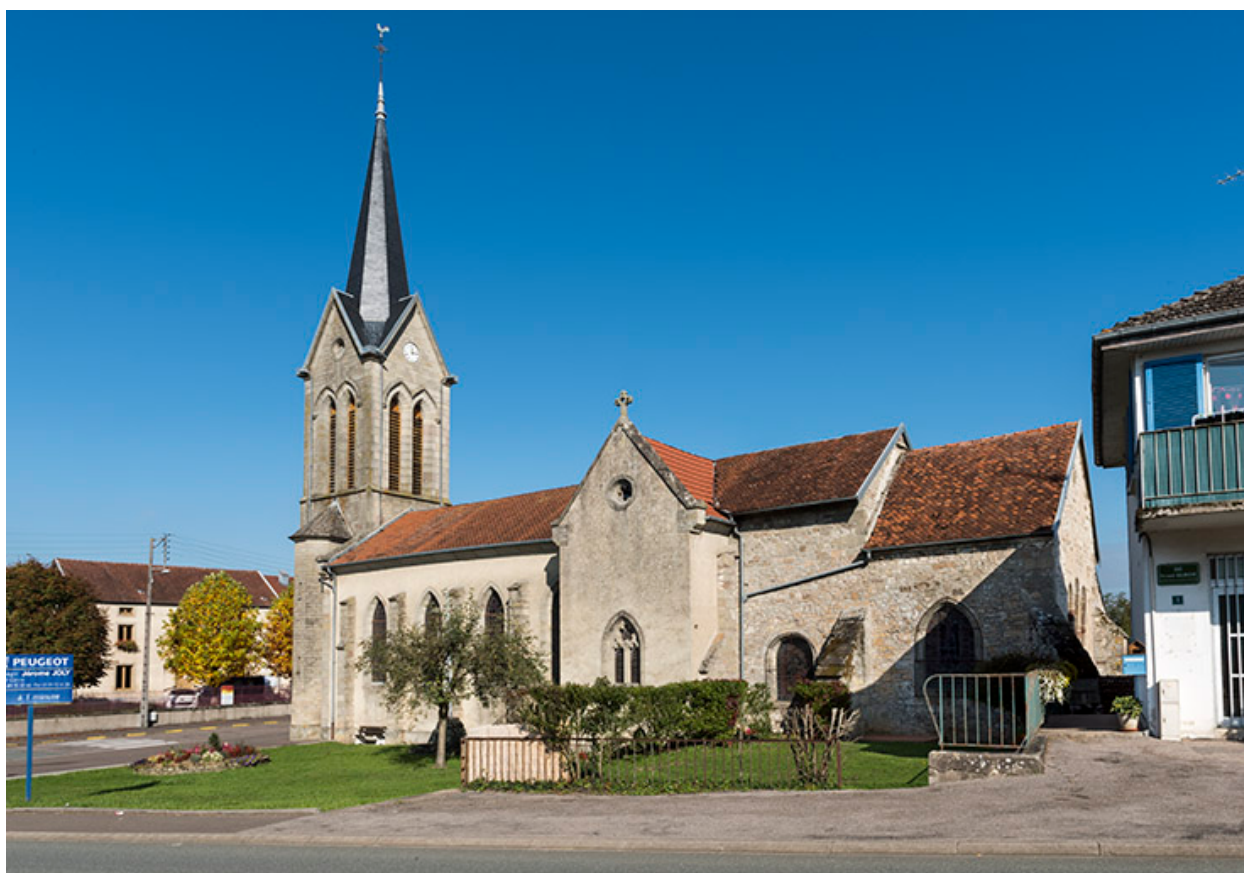
Vue d'ensemble sud-est.
