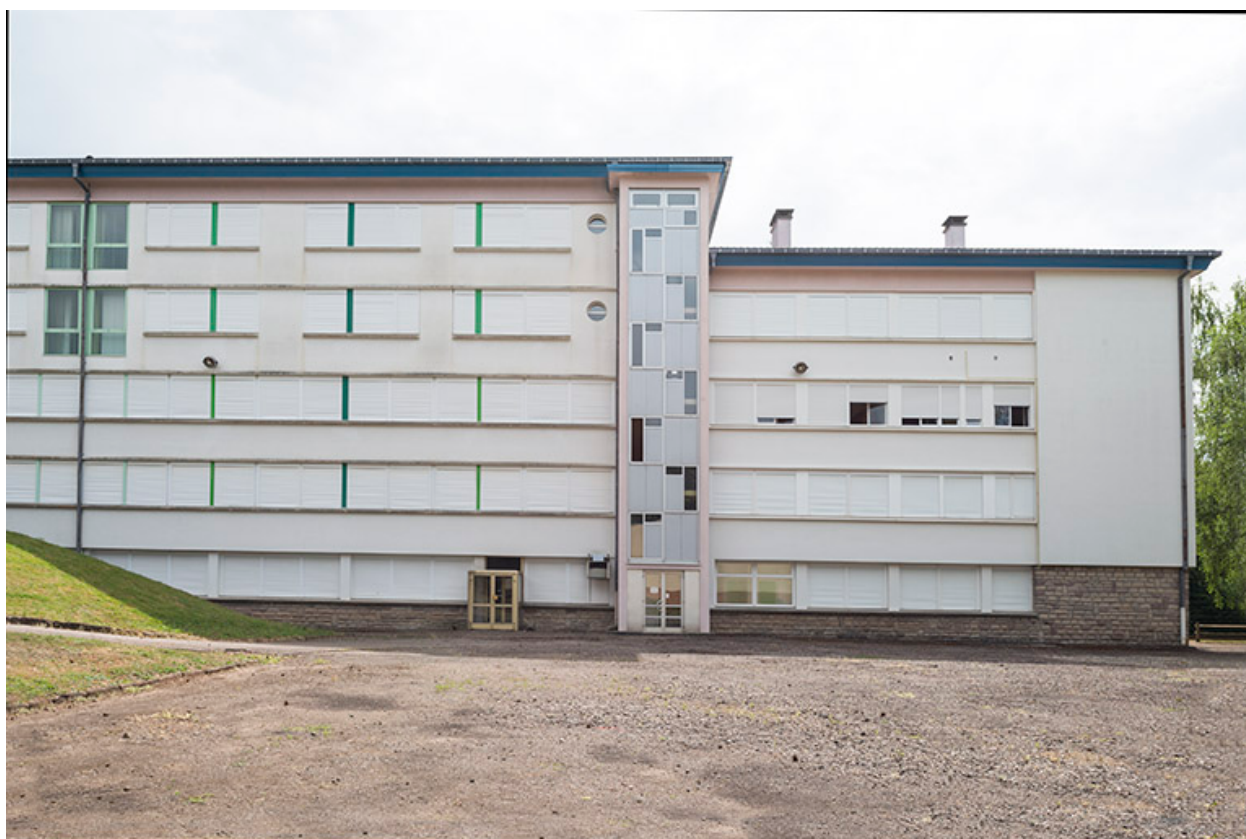
Externat : façade postérieure.
