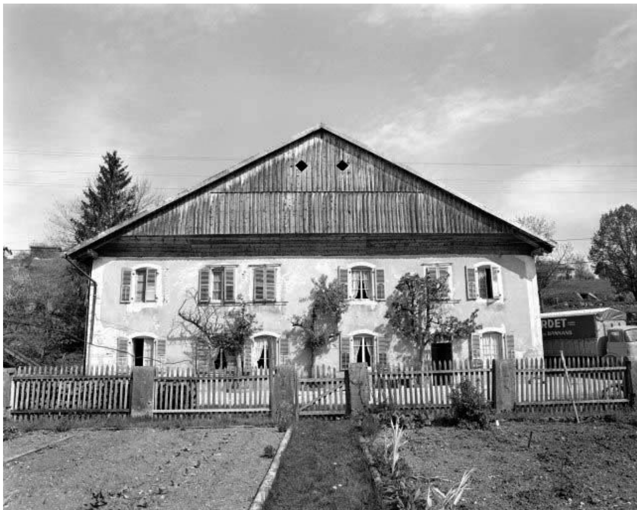
Facade antérieure et clôture du jardin-potager.
