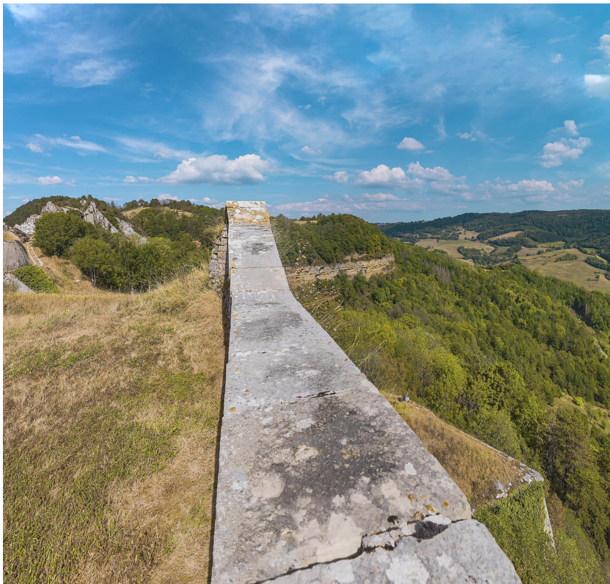
Parapet du front sud.
