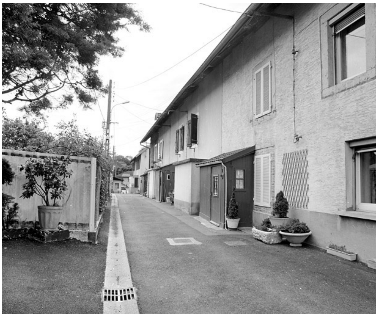
Façades est rue des Bouleaux.
