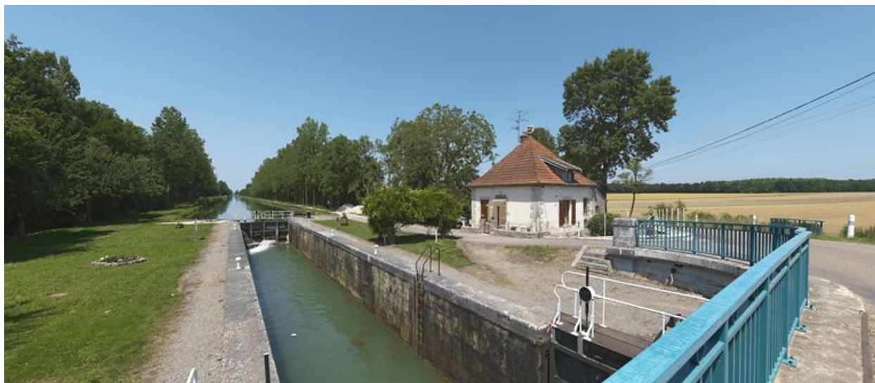
Vue d'ensemble du site prise d'aval.
