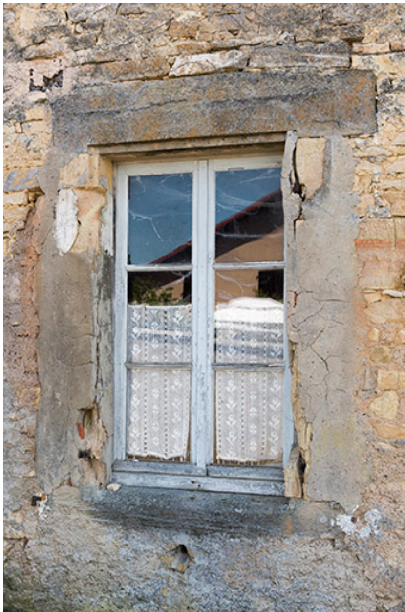
Détail d'une ouverture, mur pignon.
