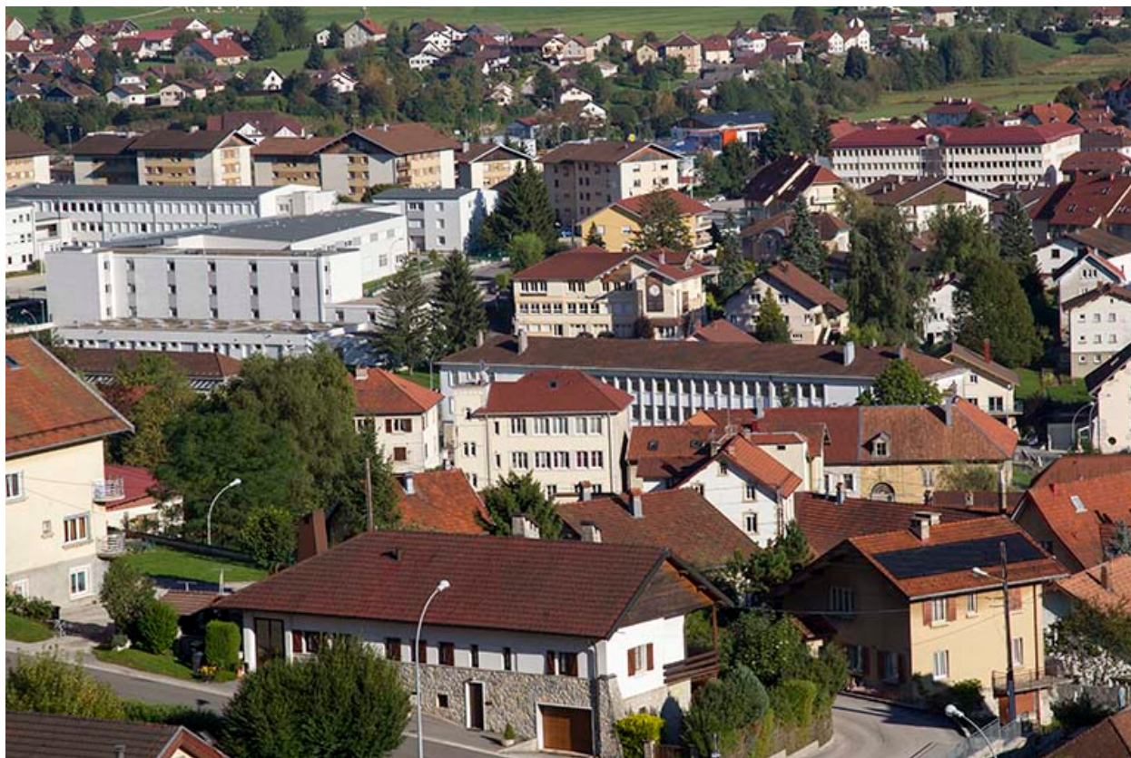
Vue d'ensemble éloignée, depuis l'ouest.
