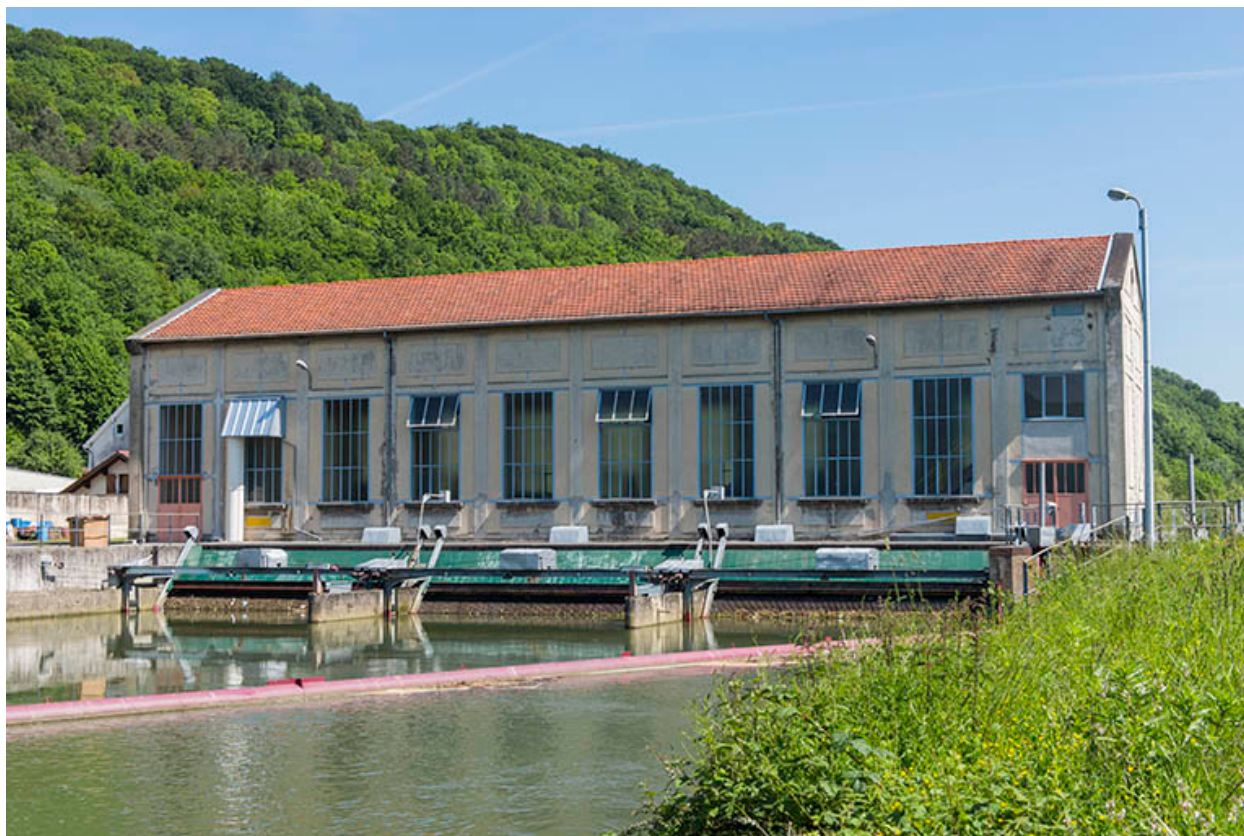
Bief d'amenée et centrale hydroélectrique.
