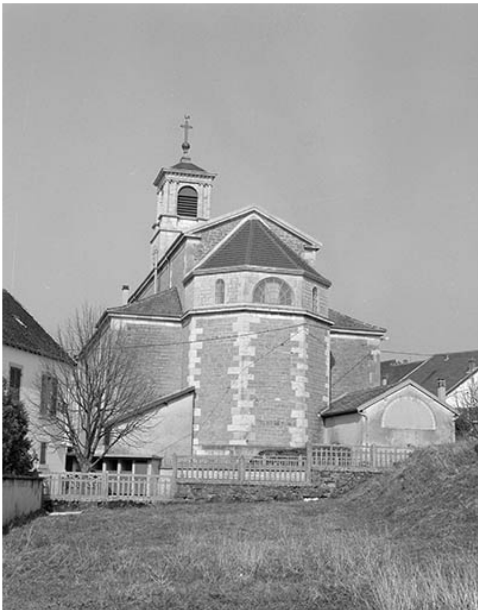
Extérieur : abside vue de trois quarts.
