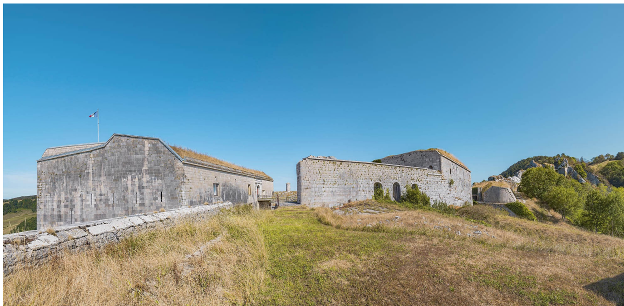
Vue générale du site depuis le sud.
