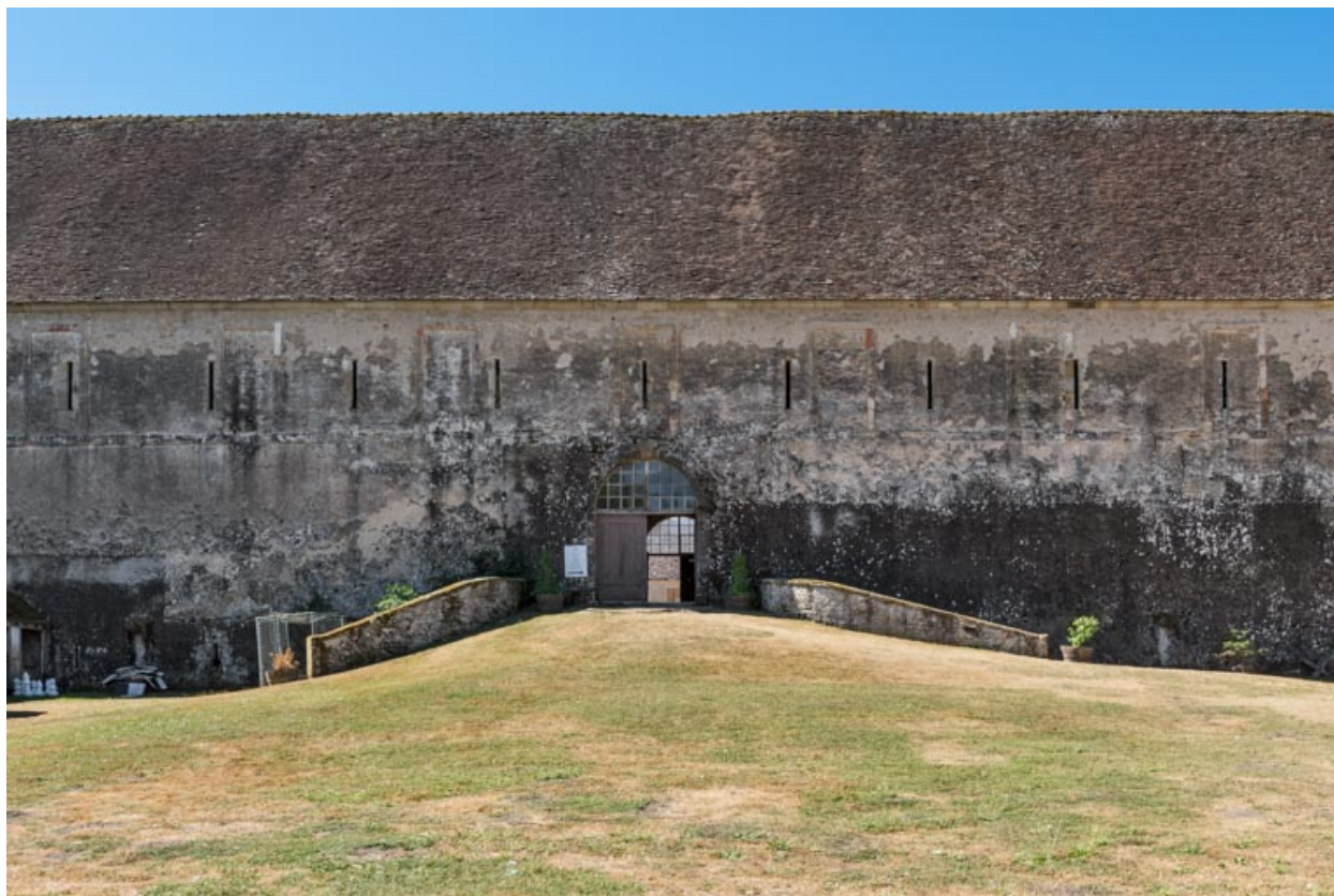
Façade postérieure : corps central.
