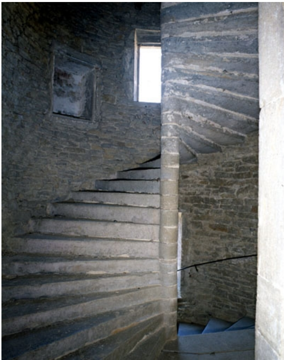
Escalier en vis de la tourelle.
