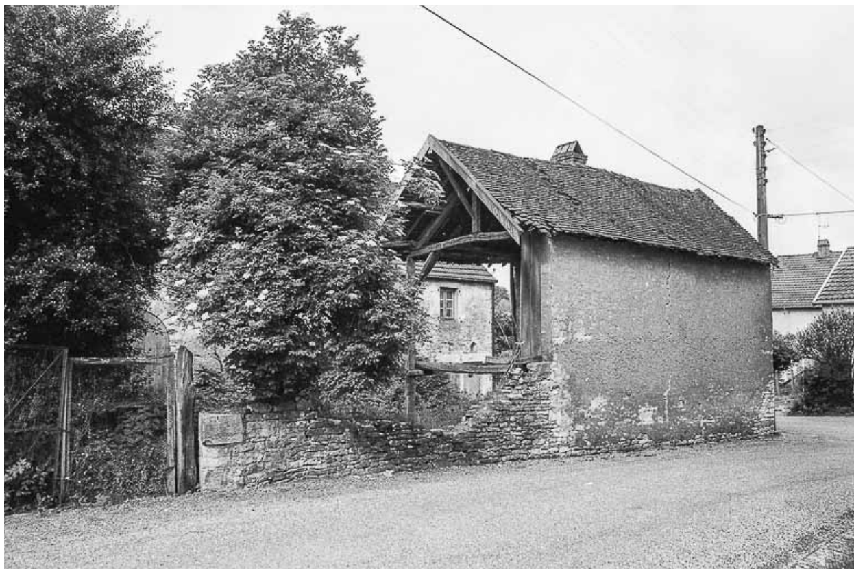
Façade postérieure de la remise.
