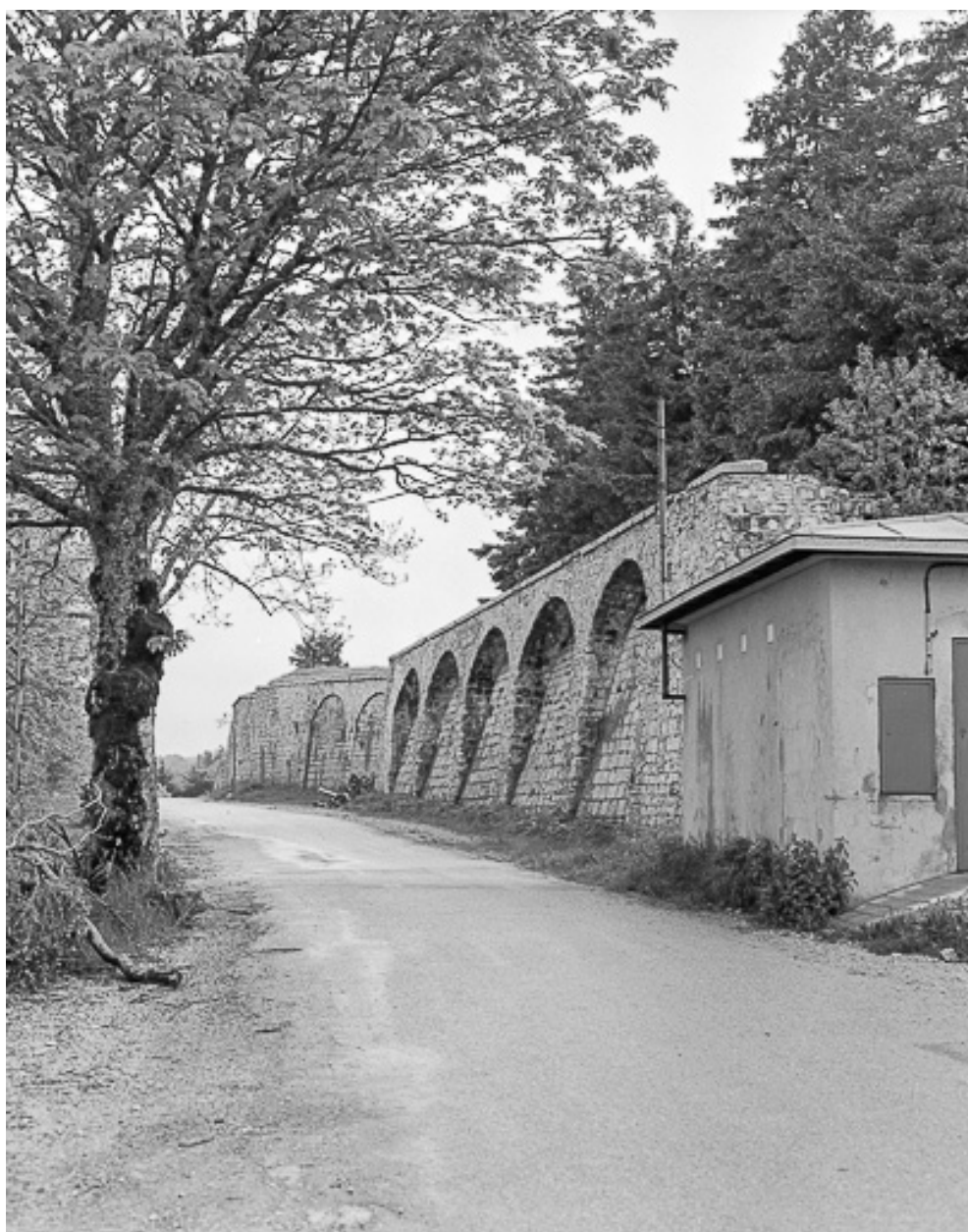
Créneaux de pied défendant l'enceinte : vue rapprochée.
