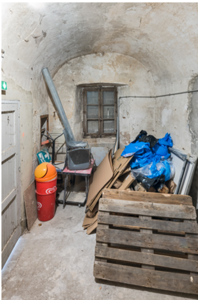
Corps nord-ouest : pièce voûtée au rez-de-chaussée.
