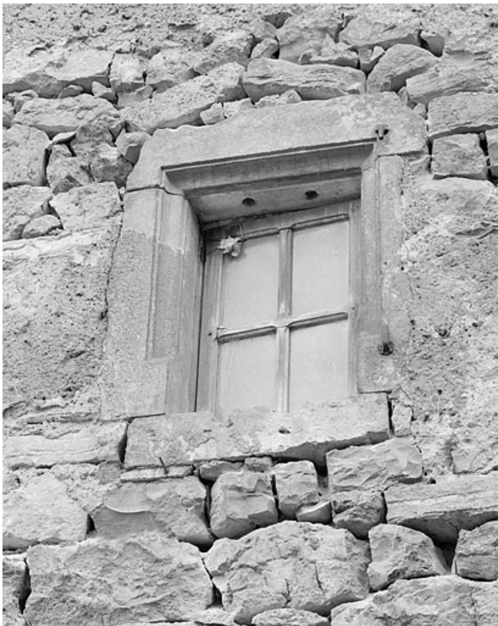
Détail d'une fenêtre sur la façade postérieure.
