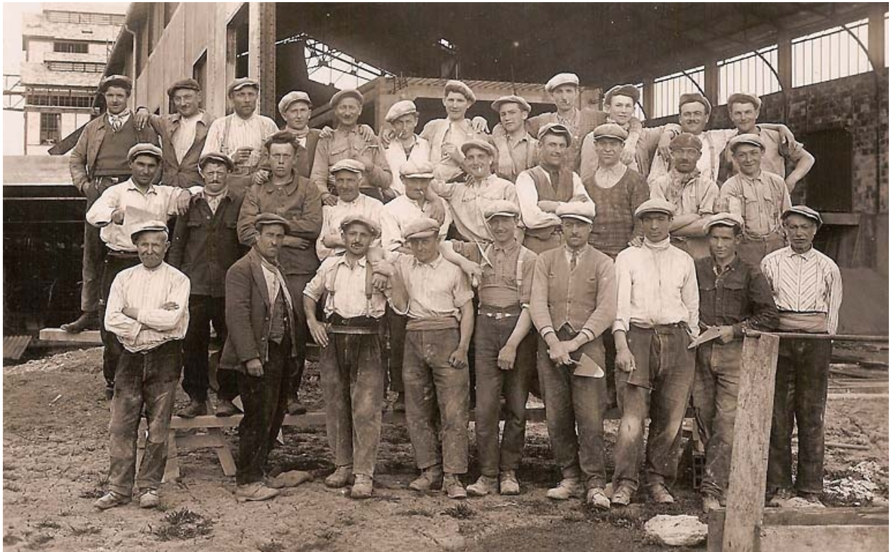
Ouvriers de l'entreprise Cilia [ ?].
