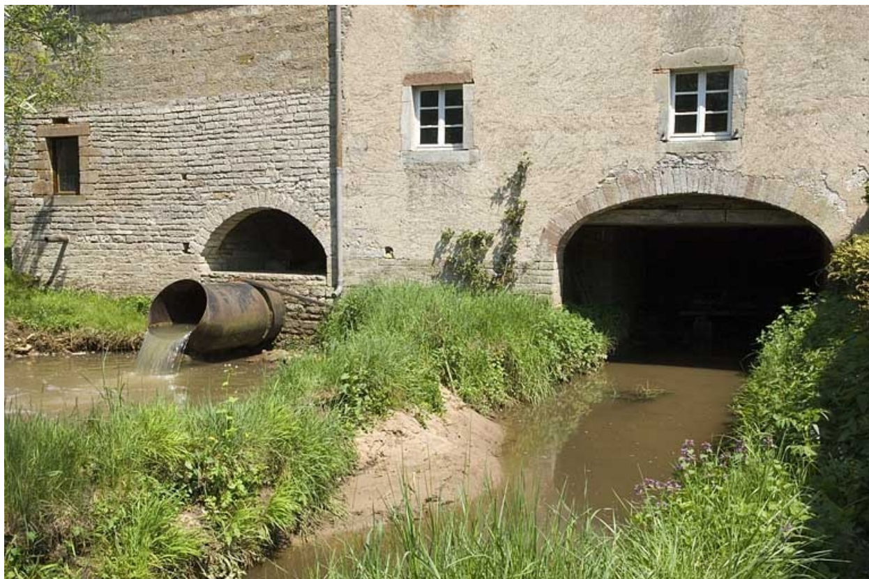
Canal de fuite.
