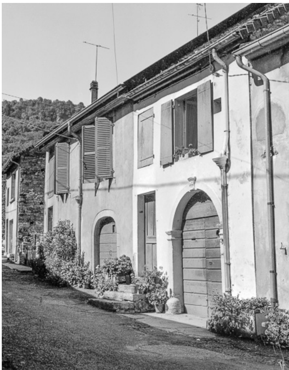
Fermes : façades sur rue.
