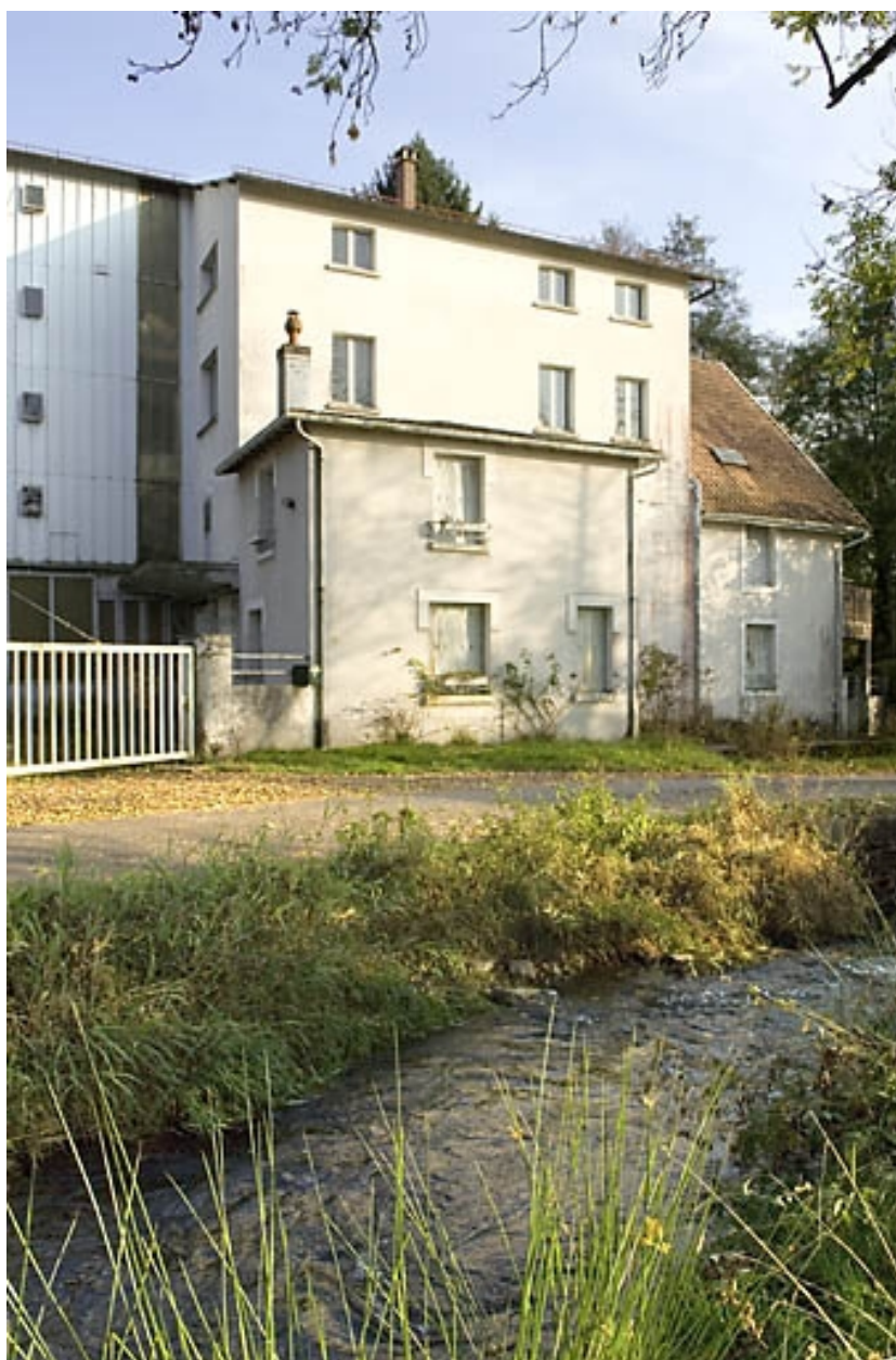
Elévation de l'atelier de fabrication.
