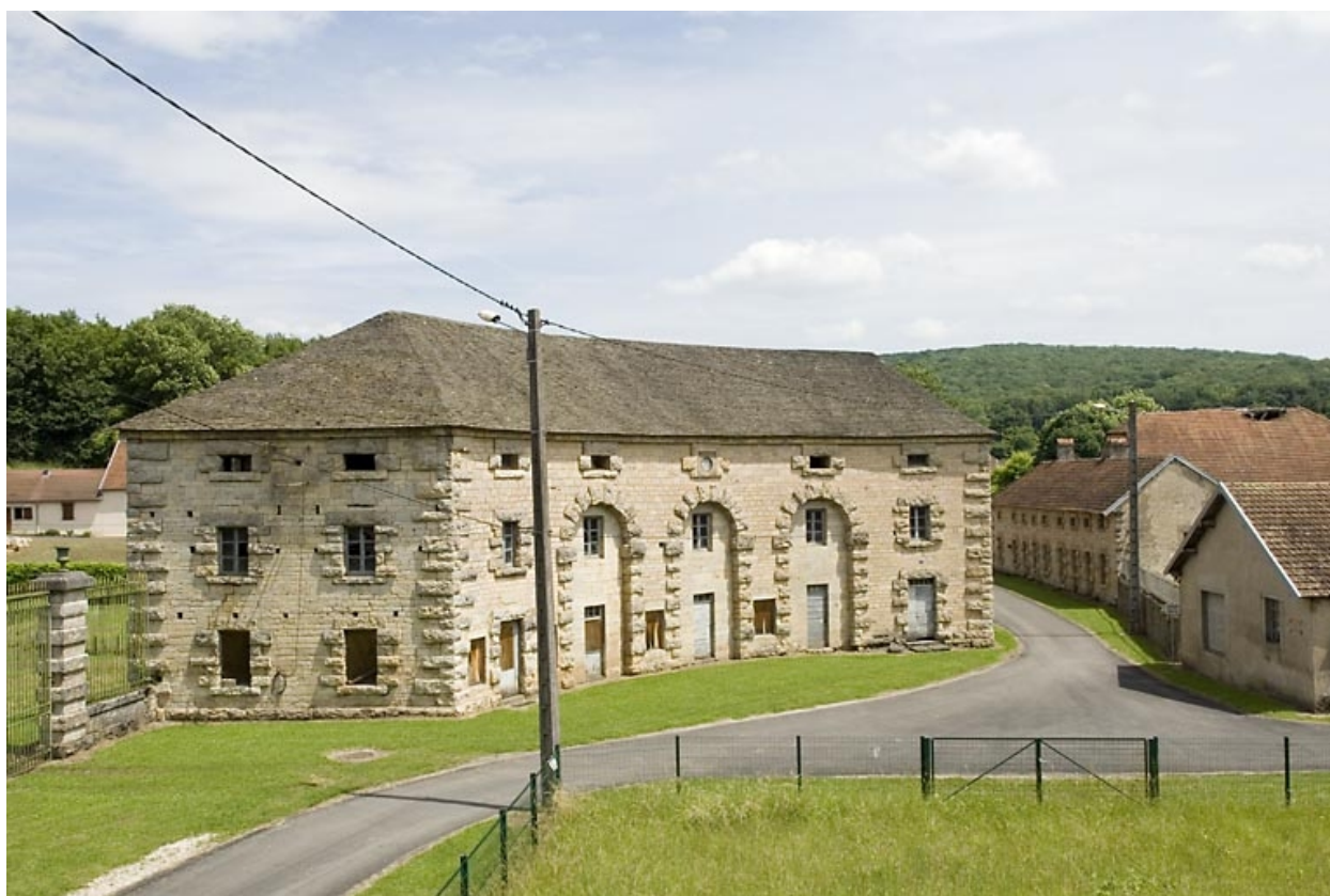
Vue plongeante sur le magasin en quart de cercle.
