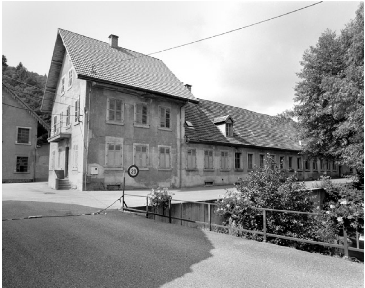
Bureaux et conciergerie depuis l'entrée.
