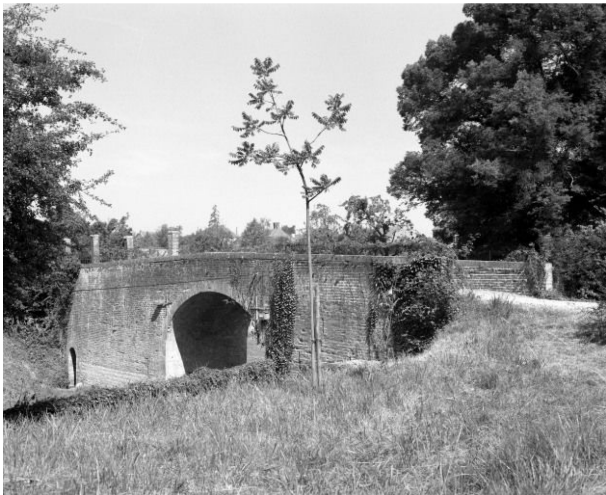
Pont reliant la cour au potager.
