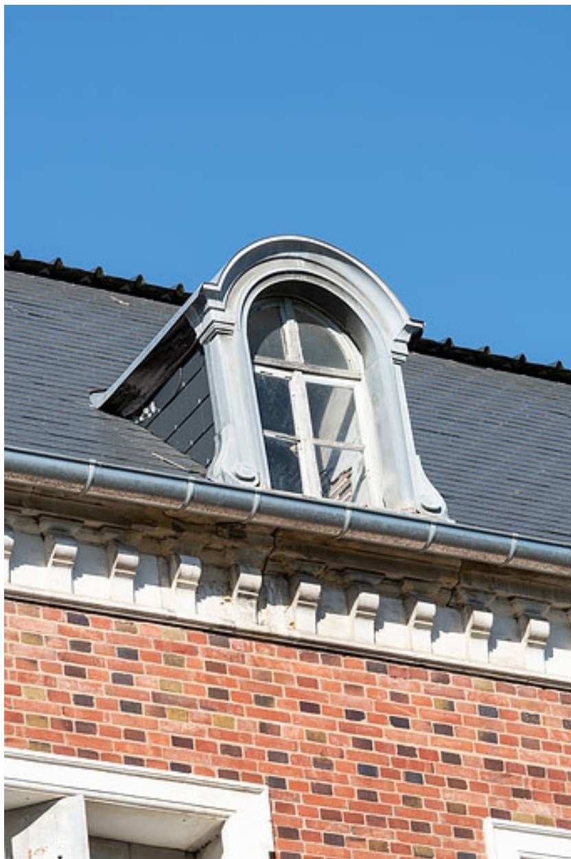
Façade de l'extension de Jules Guimard, lucarne.
