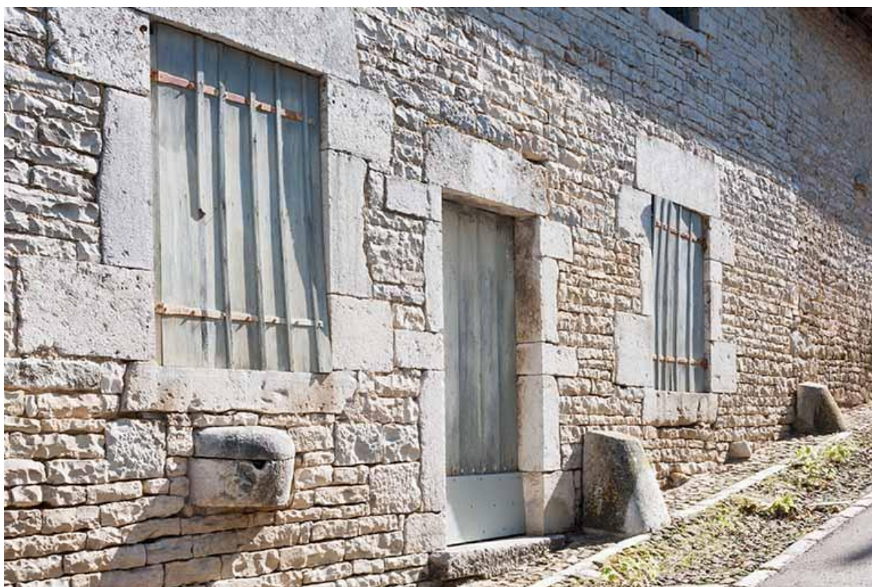
Baies de la façade ouest
