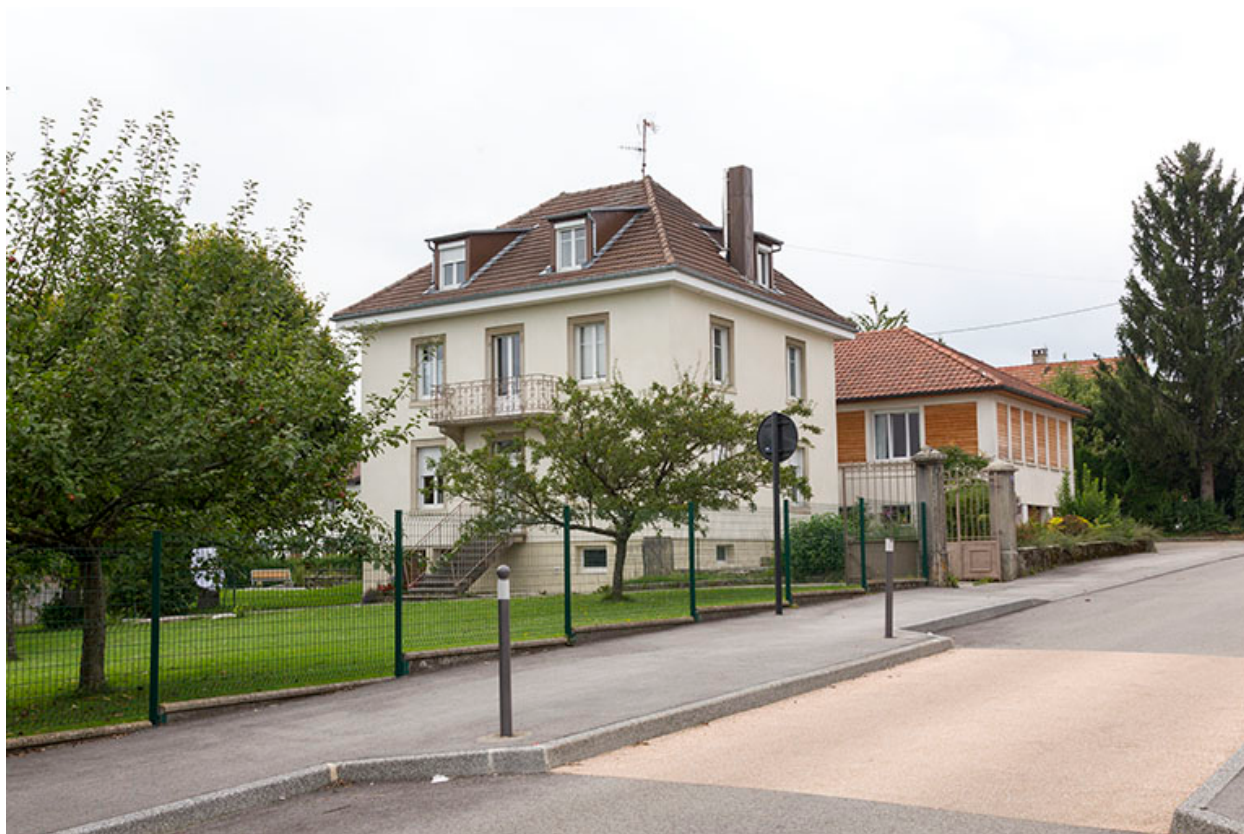
Vue d'ensemble du site, depuis l'est.
