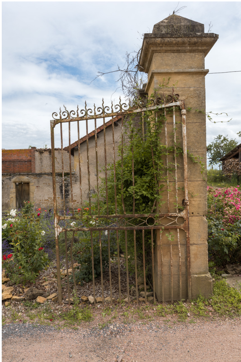
Détail du portail d'entrée de la demeure.
