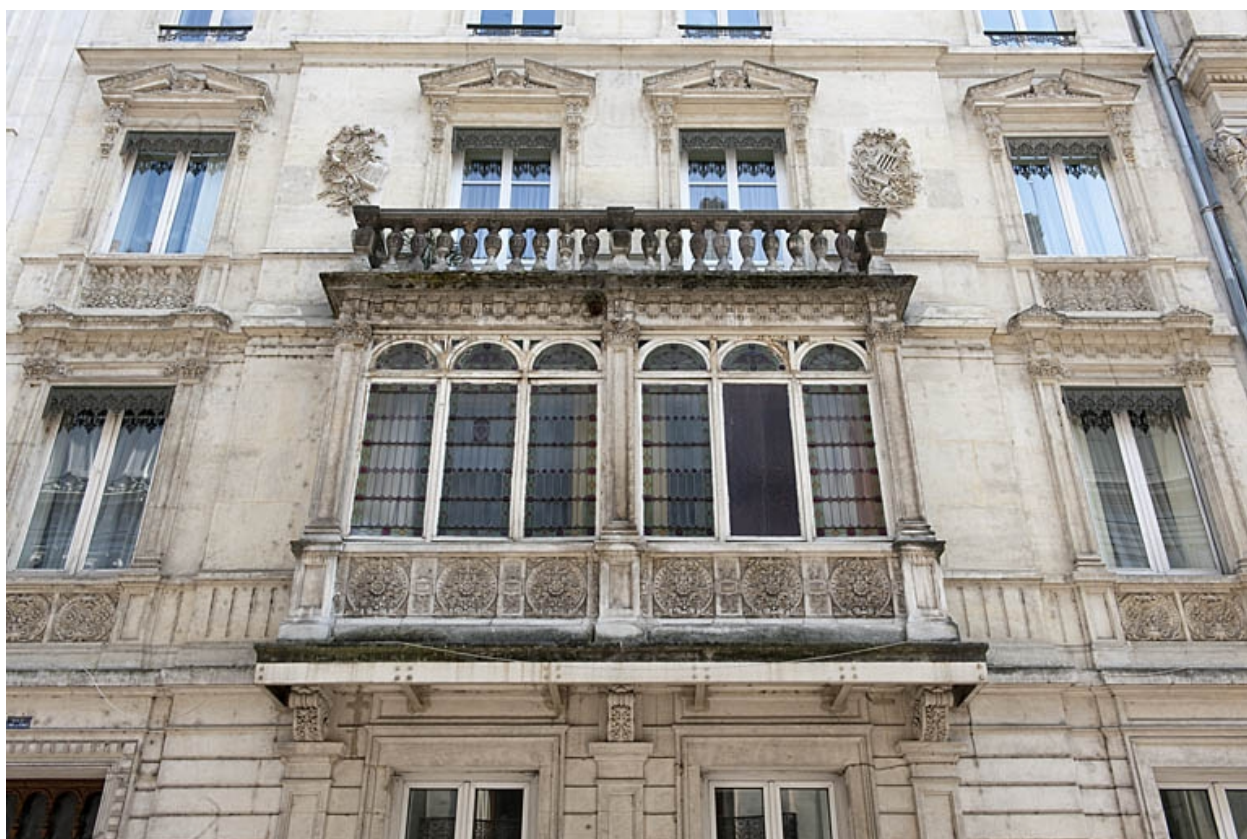
Façade antérieure : détail du bow-window de face.
