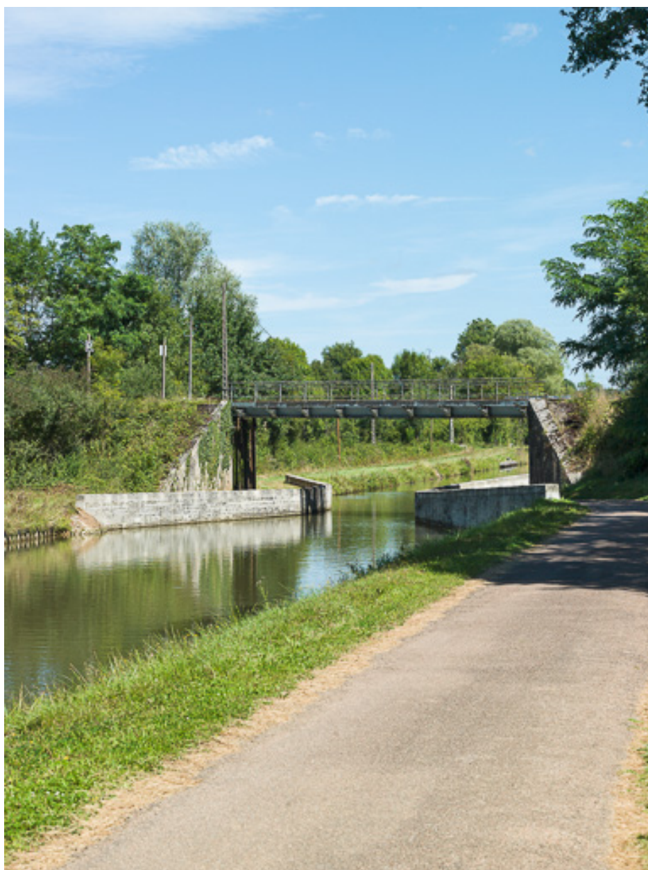
Vue d'ensemble du pont.
