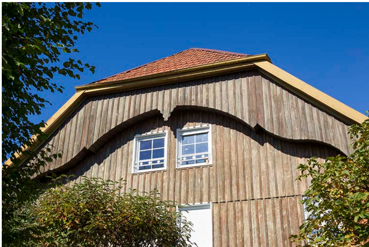
Ferme, façade latérale gauche : lambrichure et rang-pendu.
