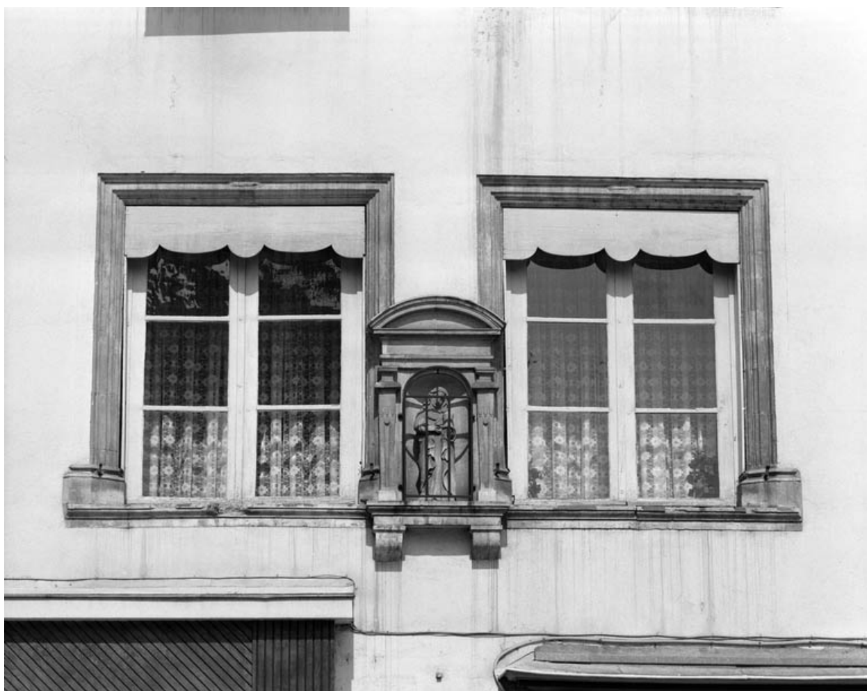
Façade antérieure : détail du premier étage.
