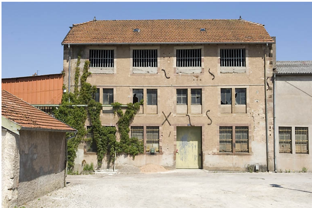
Façade sud du moulin à papier.
