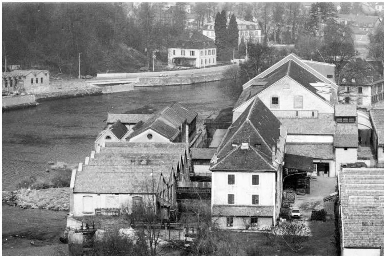
Vue plongeante depuis le sud en 1983.
