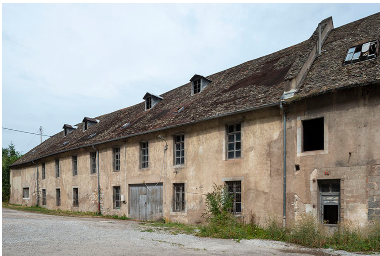
Façade sud de l'atelier de fonderie.
