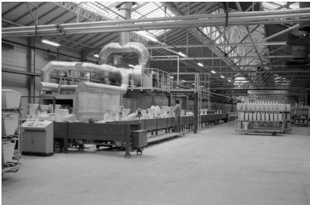
Atelier (9) : avant du four Riedhammer.
