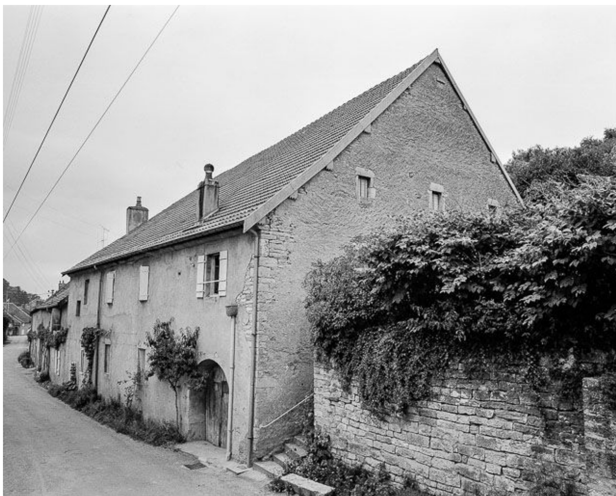
Maison située 7 chemin des Ecoliers.
