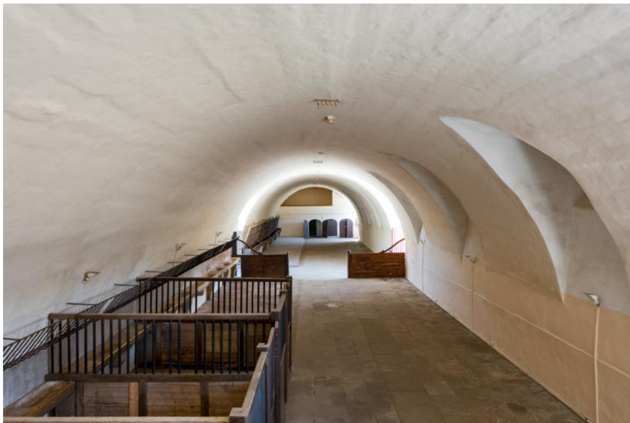
Ecurie : la voûte depuis la tribune occidentale.
