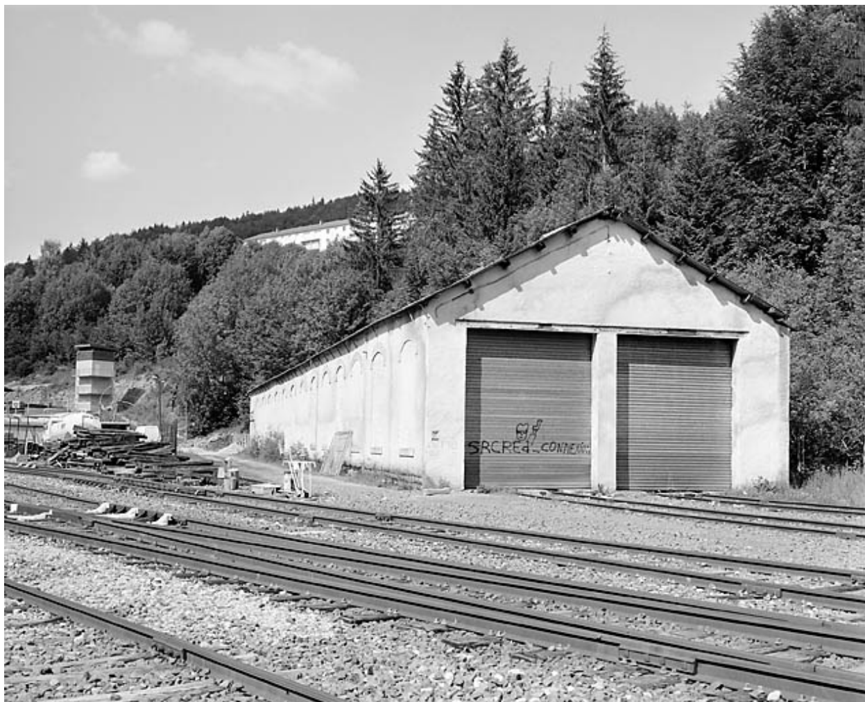
Remise ferroviaire, depuis le sud.
