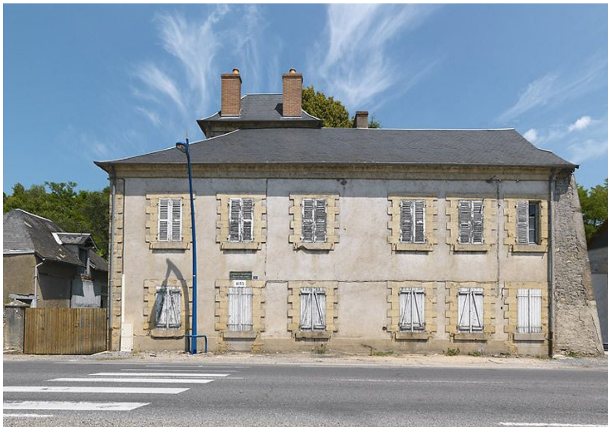
La maison éclusière, vue de face.
