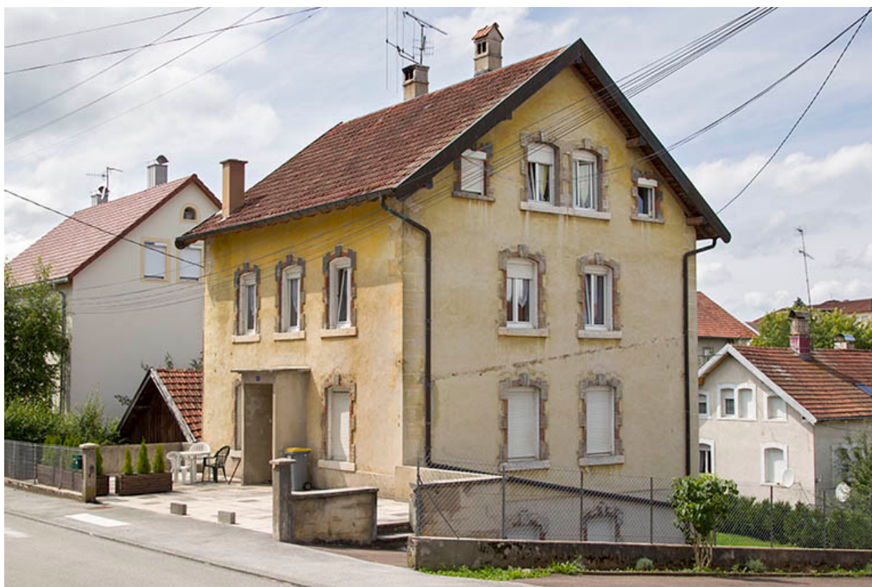
Façades antérieure et latérale droite.
