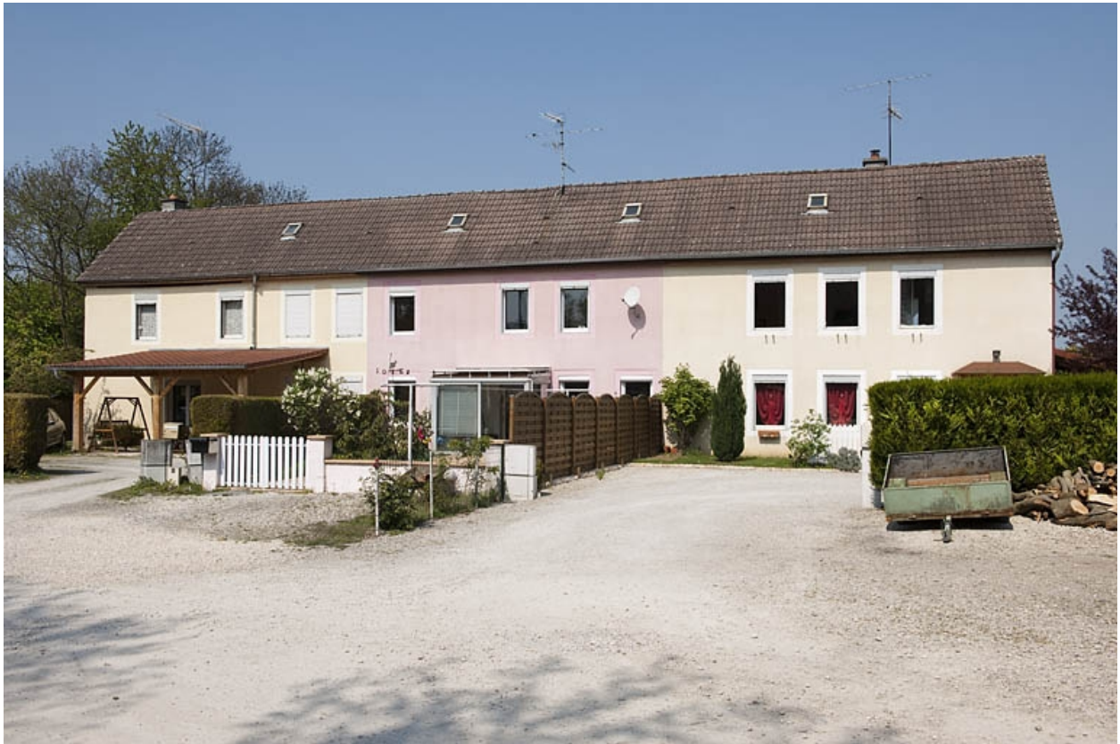
Bâtiment des magasins, remises et logements.
