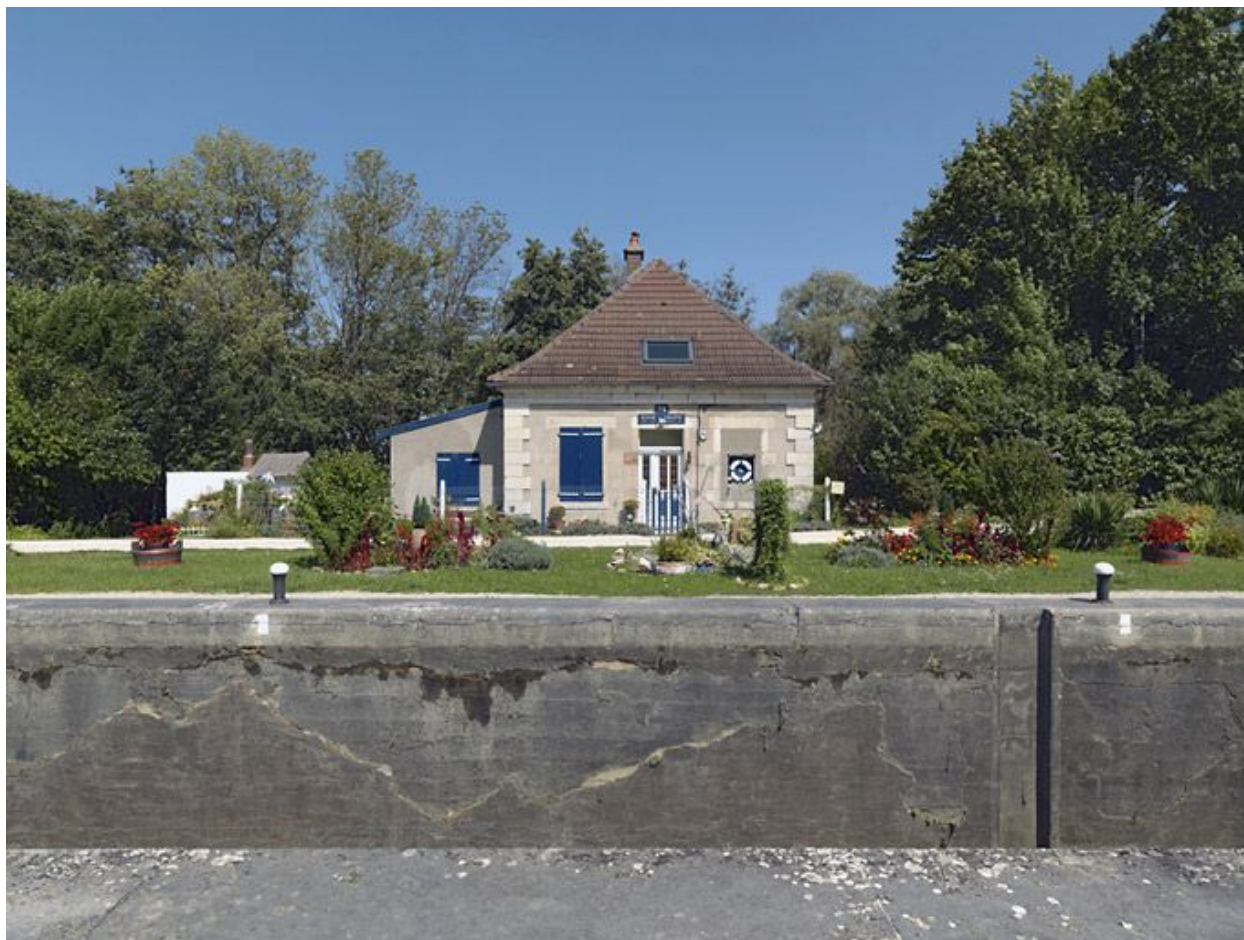
Maison éclusière vue de face.
