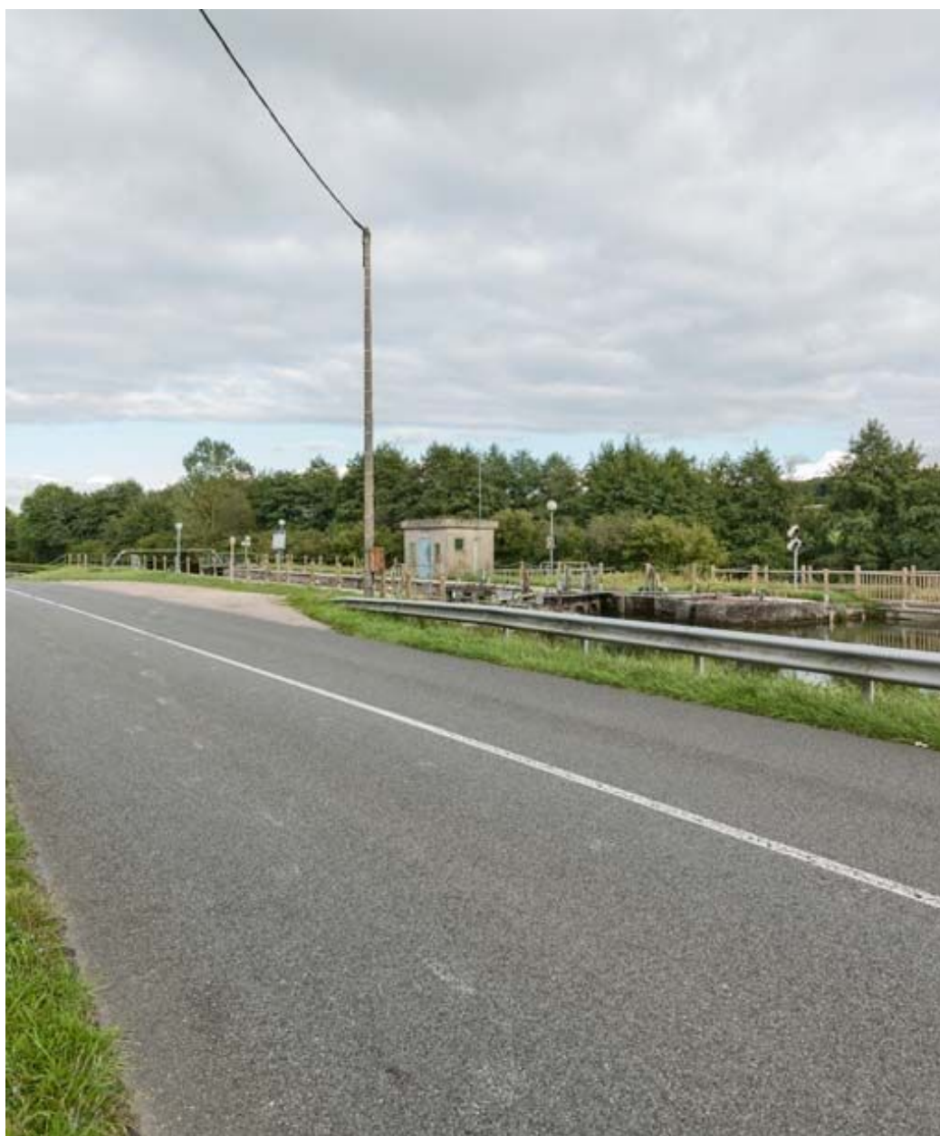
Vue d'ensemble du site d'écluse.
