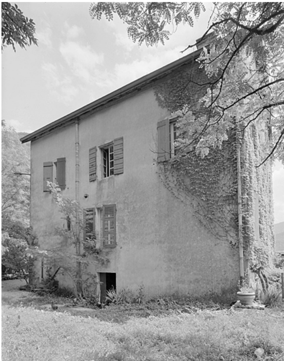
Façade droite avec accès au sous-sol.
