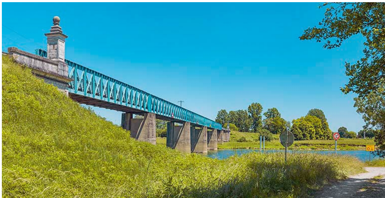
Vue d'ensemble du pont.
