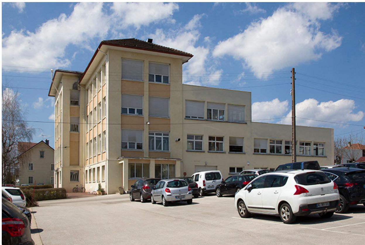
Façade latérale droite.
