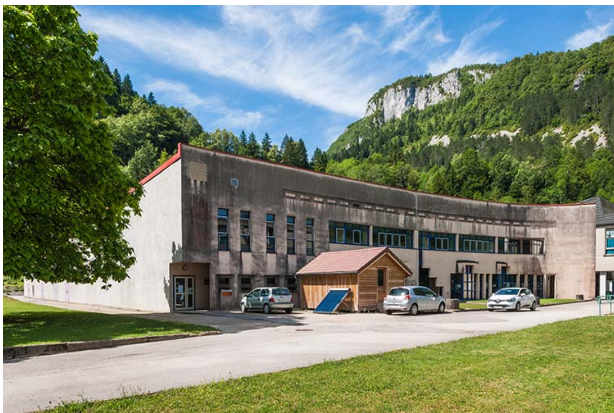
Atelier, ancien atelier mécanique : vue d'ensemble.
