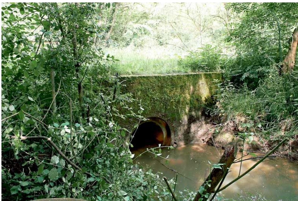
Vue d'ensemble d'un ponceau à Rancy.
